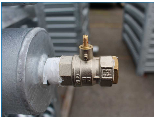
Attacco batteria superiore con valvola limitatrice di pressione sulle torri di raffreddamento a circuito chiuso con attacchi fino a DN 100.
