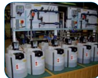
Installation du module BCP
